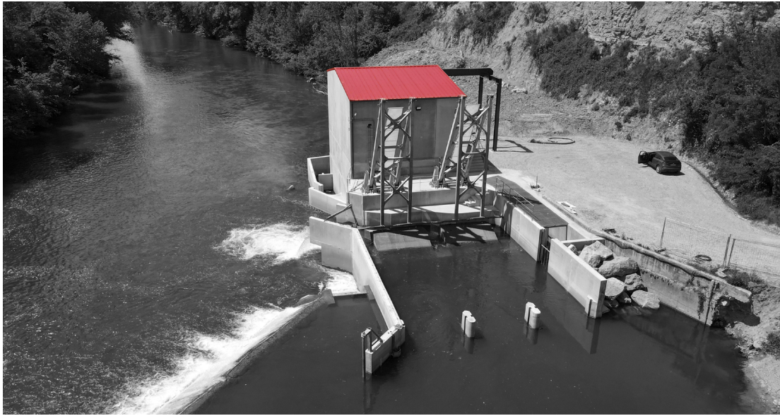
© Eiffage Énergie Systèmes
