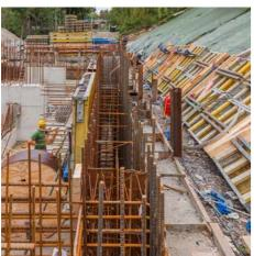
Trennung von Rein- und Schmutzwasser im Zuge des Emscherumbaus, offener Kanalbau bis 8 m Tiefe, 1.500 m³ Stahlbeton für Ortbetonschächte, Rohrvortriebe im Teilschnitt und Hydroschildverfahren bis DN 2.000.
