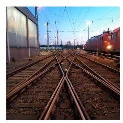
Im Frühjahr 2020 wurde im Bahnhof Saarbrücken Rbf die Gleiserneuerung von 16 Bahnhofsgleisen mit vollständiger Bettungserneuerung und zusätzlich die Weichenerneuerung von 18 Weichen mit vollständiger Bettungserneuerung durchgeführt.
