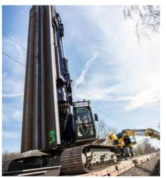
Auf der Strecke 2000 Dortmund – Hamburg in den Abschnitten Werne (km 8,800 bis 12,231) und Ascheberg (km 26,268 bis 28,200) wurde die Dammlage mit einem fangedammartigen Stützbauwerk aus Spundbohlen mit Stahlbetongurt stabilisiert.
