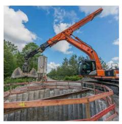
Bau eines Abwasserkanals in 15 m Tiefe auf einer Länge von 5,9 km mit 12 Schachtbauwerken in Ortbetonbauweise, Rohrvortrieben DN 800 bis DN 2.800 und offener Kanalbau.
