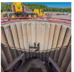
10.000 m² provisorische Baustraßen, circa 300.000 m³ Bodenaushub, circa 7.000 m³ Stahlbetonbau in 28 Ortbetonbauwerken, 13 Bohrpfahlbaugruben, 9 Spritzbetonbaugruben circa 2,5 km Vortriebe DN 2600-DN 1600 circa 1 km offener Kanalbau DN 1800-DN 300.
