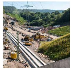
Bau der Festen Fahrbahn (System Rheda 2000) in 5.825 m langen, zweigleisigen Abschnitten mit vier eingleisigen Tunneln und mehreren Trögen und Erdkörpern sowie Festen Fahrbahnen auf langen und kurzen Brücken.
