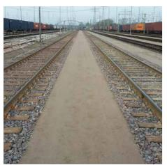
Im Rahmen der vertraglich beauftragten Leistungen im Bahnhof Alte Süderelbe in Hamburg wurden die Gleise ASE 563 sowie die Weichen 562, 563, 564, 565, 566 und 567 umgebaut und das Gleisbett vollständig erneuert.
