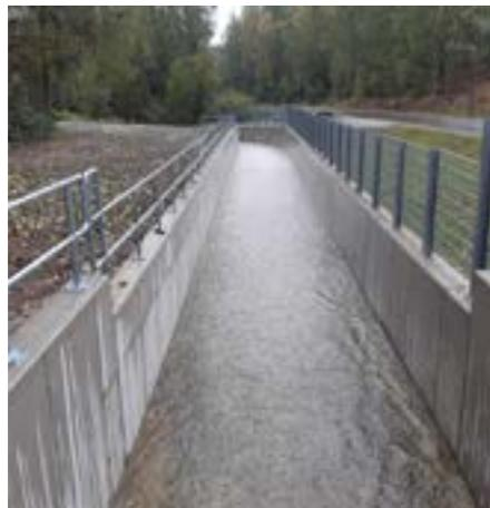
Die Stauanlage der Revierwasserlaufanstalt Hüttenteich brauchte eine anforderungsgerechte Hochwassersicherheit auf Grundlage der DIN 19700/11. Eiffage Infra-Ost errichtete eine entsprechende Hochwasserentlastungsanlage wie auch einen Ersatzneubau der Zufahrtsbrücke zum Betriebsgelände des Hüttenteiches.
