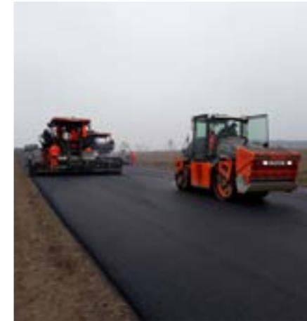
Bei der B 101, Ortsumfahrung Luckenwalde, wurde auf über drei Kilometern Länge die Fahrbahn erneuert. Dafür wurden circa 51.400 Quadratmeter Asphaltdeckschicht und Asphaltbinderschicht aus der Straße gefräst. Die Fahrbahnerneuerung erfolgte mit 51.400 Quadratmeter Asphaltbinderschicht und mit 51.400 Quadratmeter Splittmastixasphalt.
