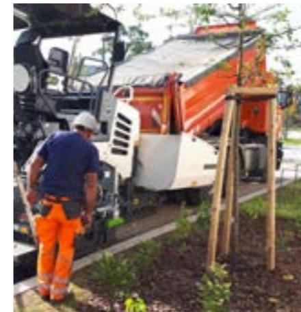
Es war eine neue Asphalttragschicht für verschiedene Teilstücke der Flaeming-Skate gefordert. Die Eiffage Infra-Ost schloss die Sanierungsarbeiten der Skateflächen im Sommer 2020 erfolgreich ab.
