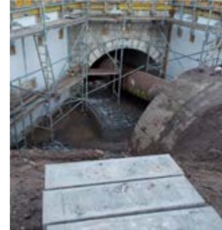
Durch ein Hochwasser im Jahr 2003 verursacht, war die Standsicherheit eines 200 Meter langen unterirdischen Brückenbauwerks gefährdet. Gefordert war, das Werk freizulegen, eine umfangreiche Medienverlegung umzusetzen und eine Straße samt Kreuzung zurückzubauen.
